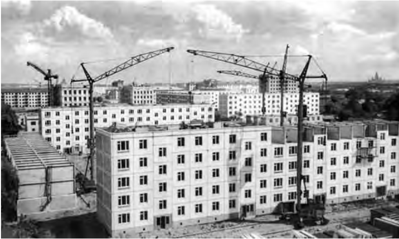
Строительство новых 5-этажных жилых домов («хрущевок»)
